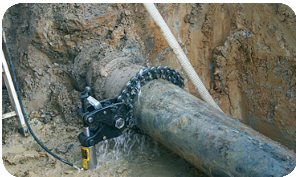
Découpe de canalisation en amiante-ciment au coupe-tube.
