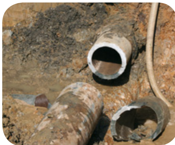
Canalisations en amiante-ciment.
