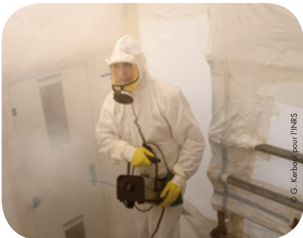
Test de fumée à l'intérieur du confinement.
