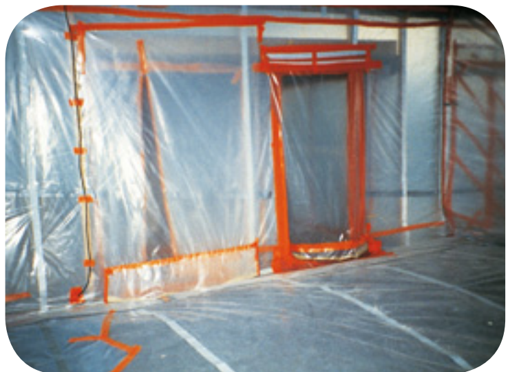
Matérialisation d'un accès pour les équipes de secours.
