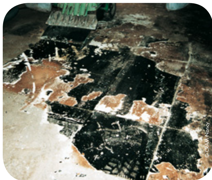
Décollement des dalles à la machine par réchauffage
