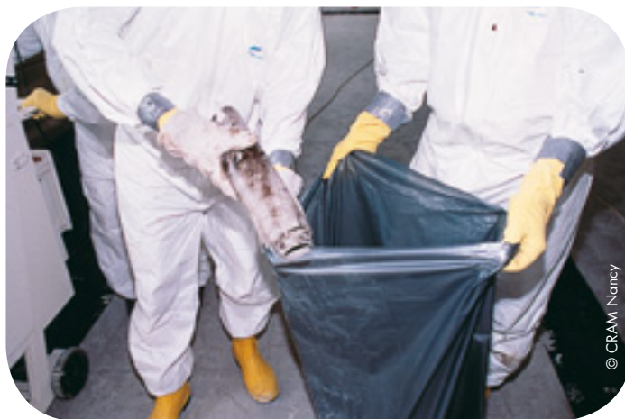
Mise en sac de déchets de revêtements de sols.
