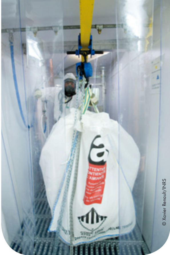
Tunnel déchets équipé de moyens de manutention.
