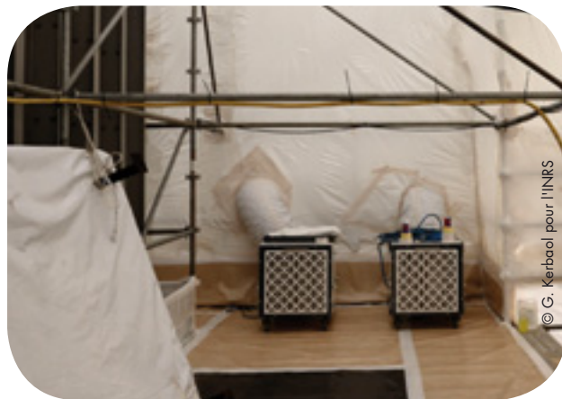
Des extracteurs dotés de filtres à très haute efficacité sont utilisés pour mettre la zone de travail en dépression.
