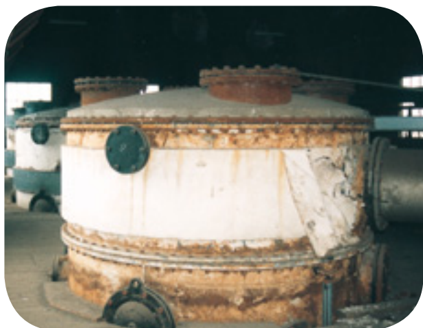
Calorifugeage sur un réacteur chimique.
