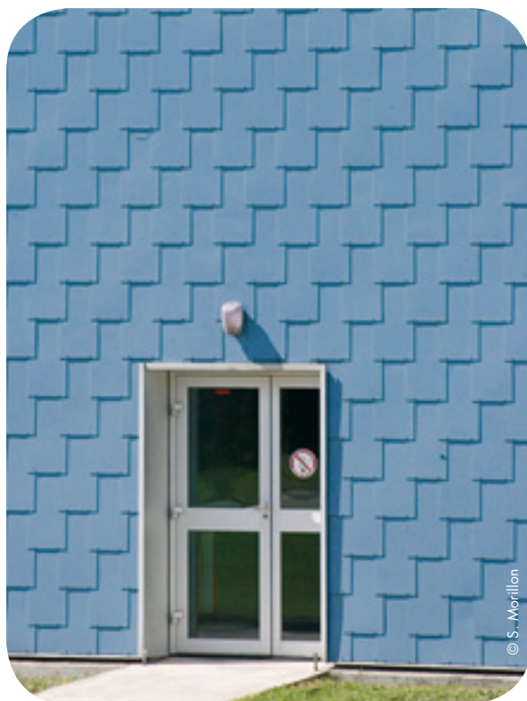
Bardage en amiante-ciment.
