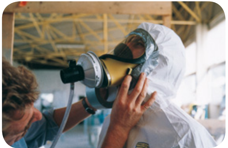
Avant l'entrée en zone, chaque opérateur fait vérifier l'étanchéité et le bon fonctionnement de son équipement par un autre opérateur (photo AFPA)
