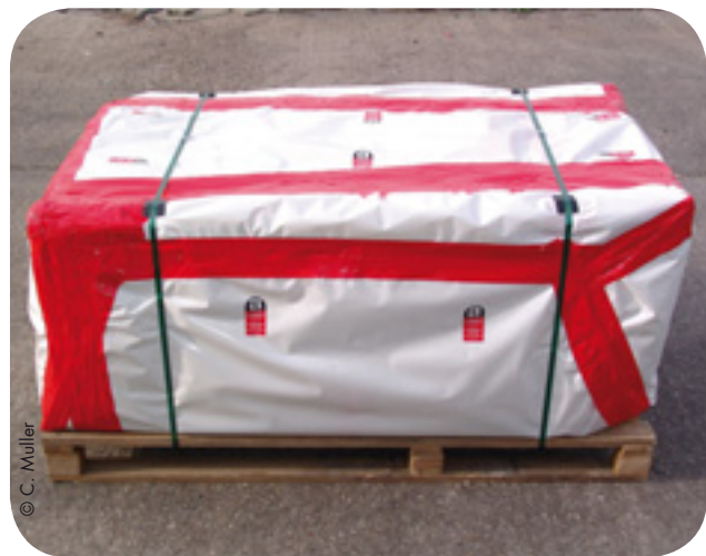
Emballage de plaques d'amiante-ciment sur palette
