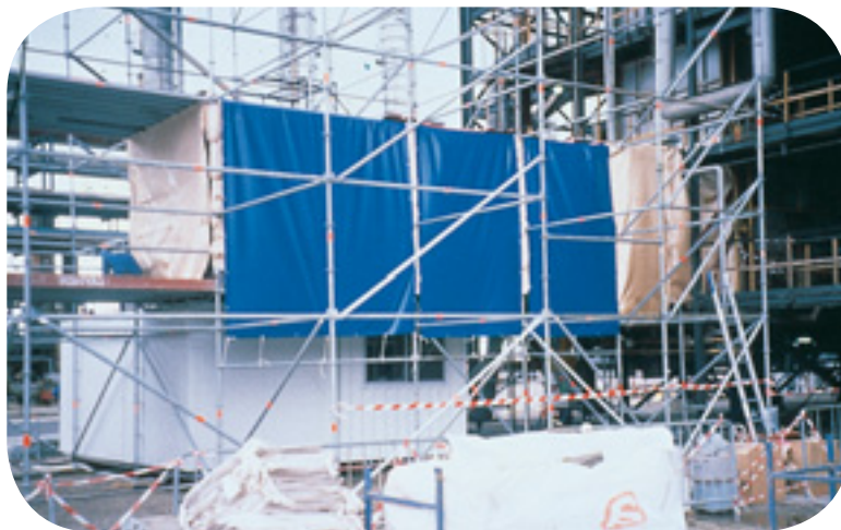
Confinement à l'extérieur d'une installation industrielle.
