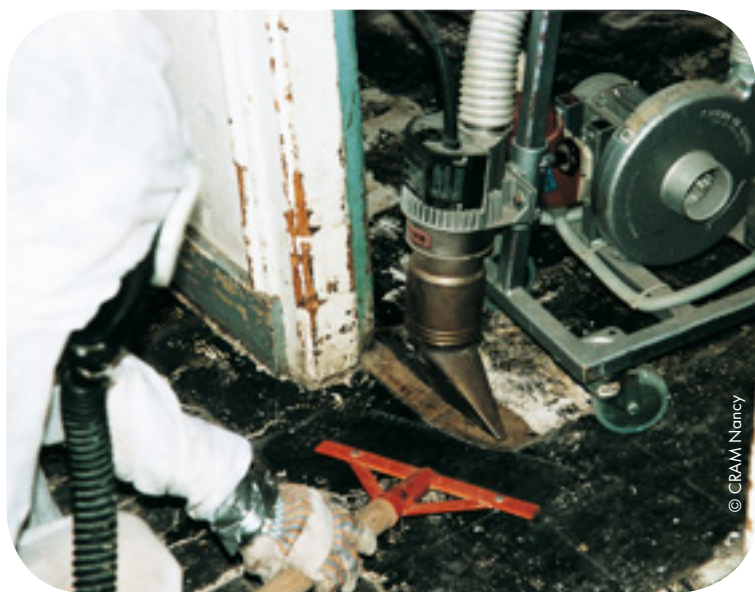
Décollement des dalles à la spatule.
