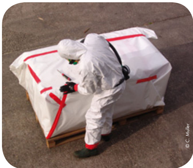
Masque complet à ventilation assistée TM3P et combinaison à usage unique de type 5
