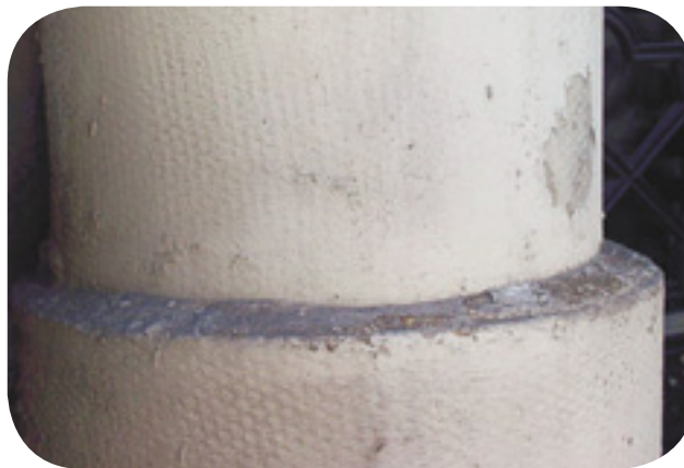
Conduite en amiante-ciment à l'intérieur d'un local
