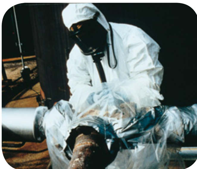
Intervention en extérieur sur une bride à trois voies, à l'aide d'un sac à gants.
