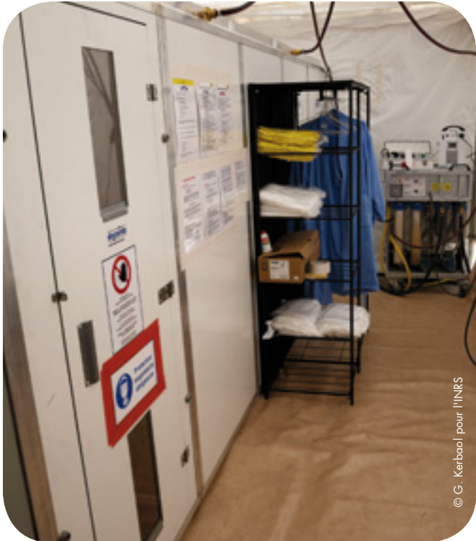
Sas de décontamination à plusieurs compartiments.
