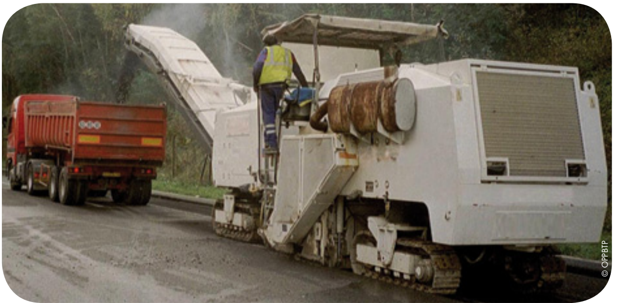
Collecte des agrégats par tapis protégé et évacuation vers une benne.
