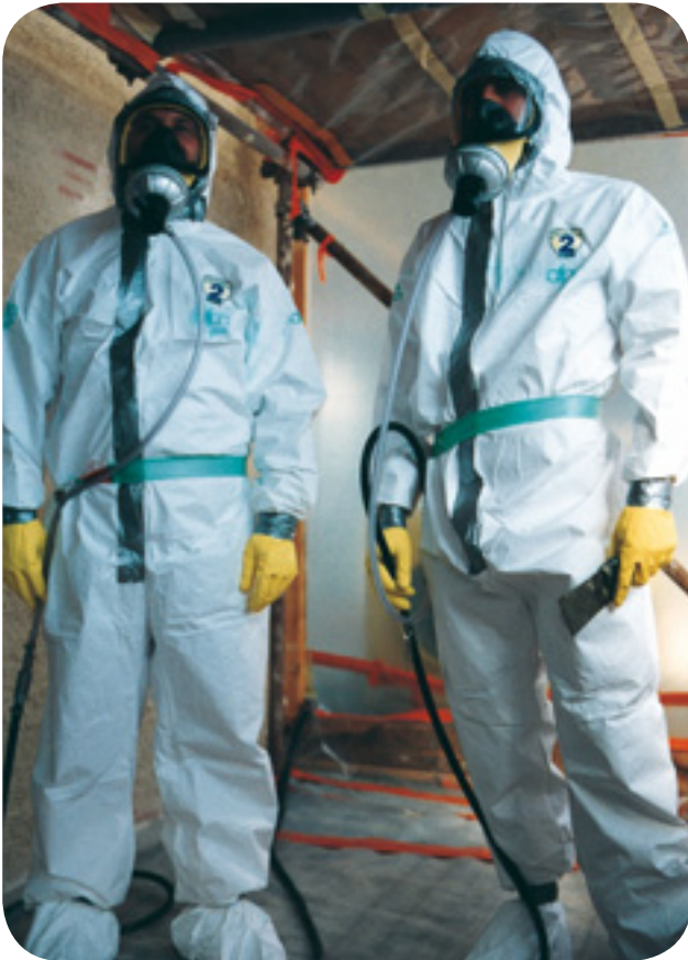
Masques complets à adduction d'air comprimé (avec filtres P3 en série). Les tuyaux doivent rester fixés à la ceinture pour éviter l'arrachage du masque (photo AFPA).
