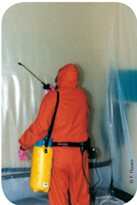
Application d'un surfactant sur les films.
