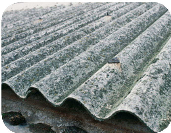
Toiture en amiante-ciment.
