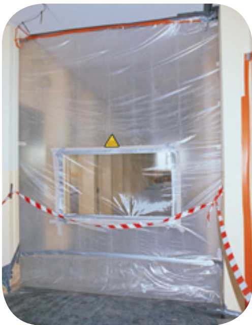
Fenêtre d'observation dans un confinement.
