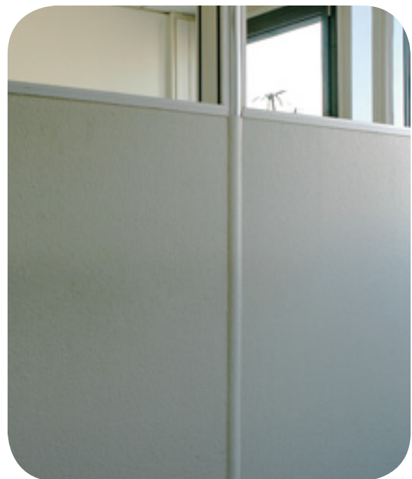
Cloison en amiante-ciment.
