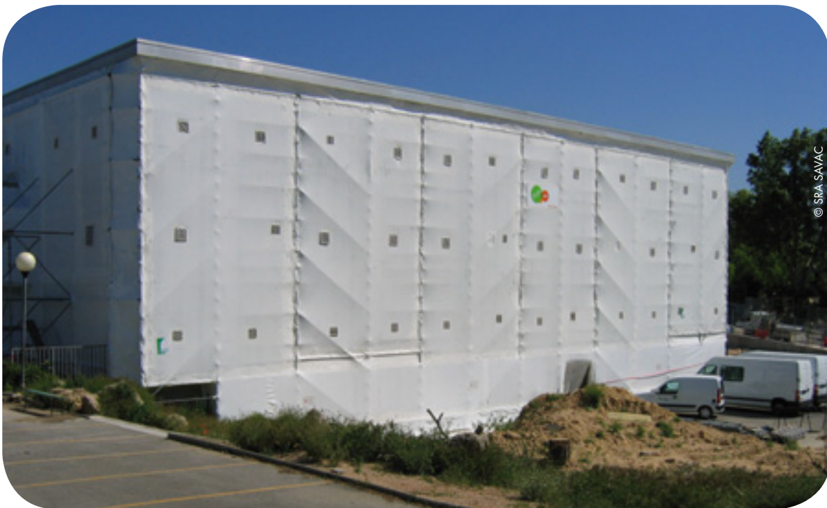
Confinement total d'un bâtiment.
